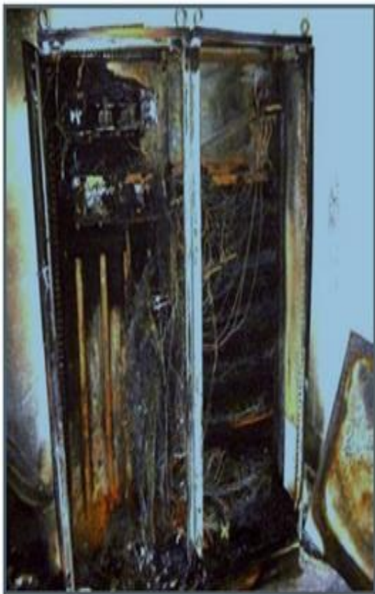
Incendio di un quadro elettrico
